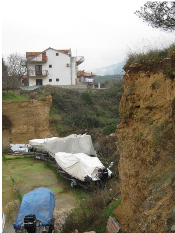
Slika 2. Potencijalno klizište na lokaciji suhe marine u Jelsi
